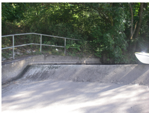
Wehr Lichtenfels rutschsichere Rampe anbauen
